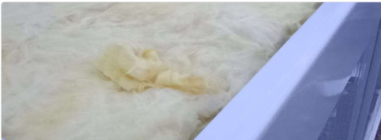
Rozloženie tepelnej izolácie po celej ploche strechy
