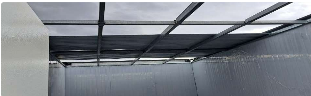
Strešná konštrukcia s profilmi vytvárajúcimi spád strechy
