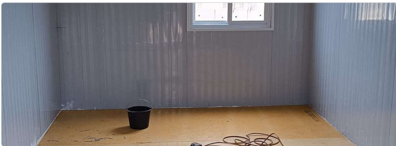
Podlahové dosky pripravené na priskrutkovanie k rámu
