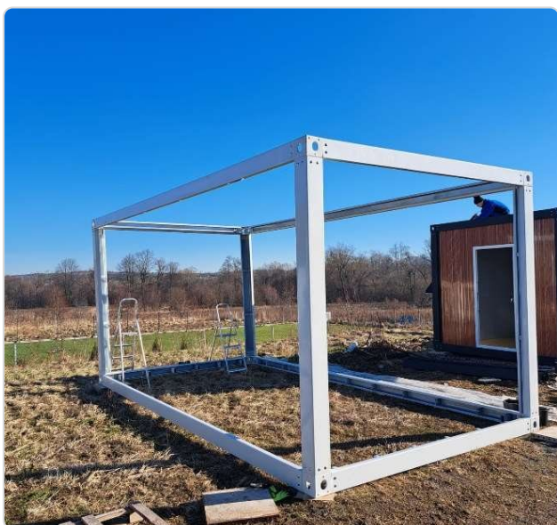
Zostavený rám kontajnera pripravený na podlahové nosníky
