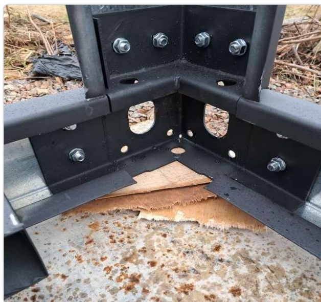
Detail skrutkového spoja rohového stĺpika
