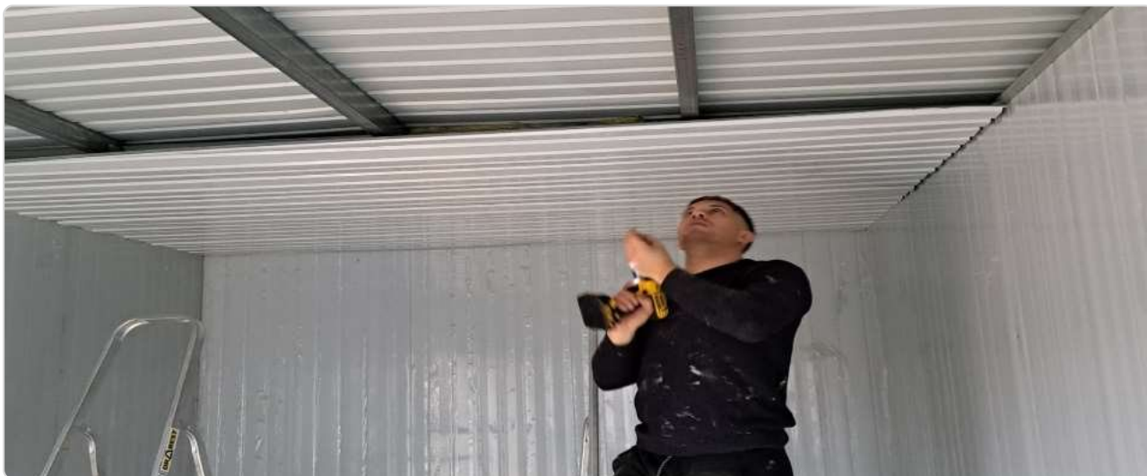
Kotvenie stropného plechu k strešnej konštrukcii
