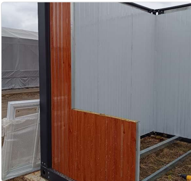
Montáž steny s otvorom pre dvere
