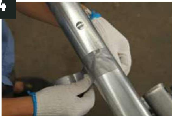
Prelepenie spojov konštrukcie páskou
